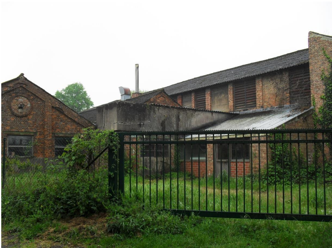
Zicht op de voormalige leerlooierij Lebegge aan de noordzijde
