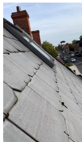
Figuur 51: dak en schoorsteen (Bron: eigen afbeelding)
