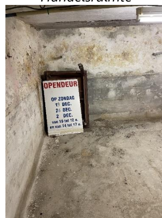
Figuur 37: kelder (Bron: eigen afbeelding)
