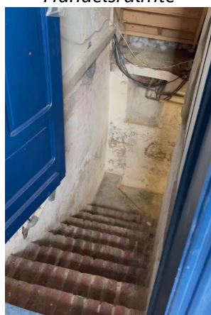
Figuur 36: kelder (Bron: eigen afbeelding)
